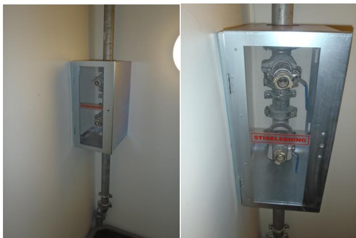
Figur 5; Godt eksempel for beskyttelse av stigeledning mot hæverk
