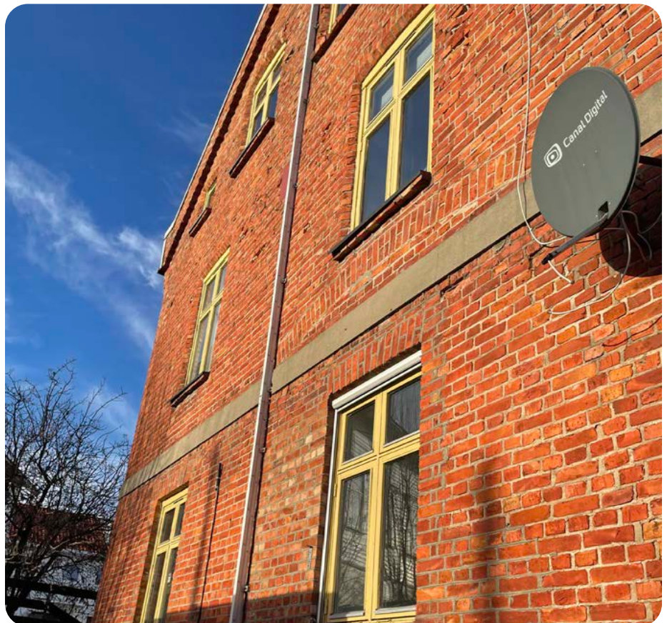
Storgata 4 i Lillesand er betegnet som en 1890-gård. I 2024 ble 11 bygninger i Lillesand kartlagt.
