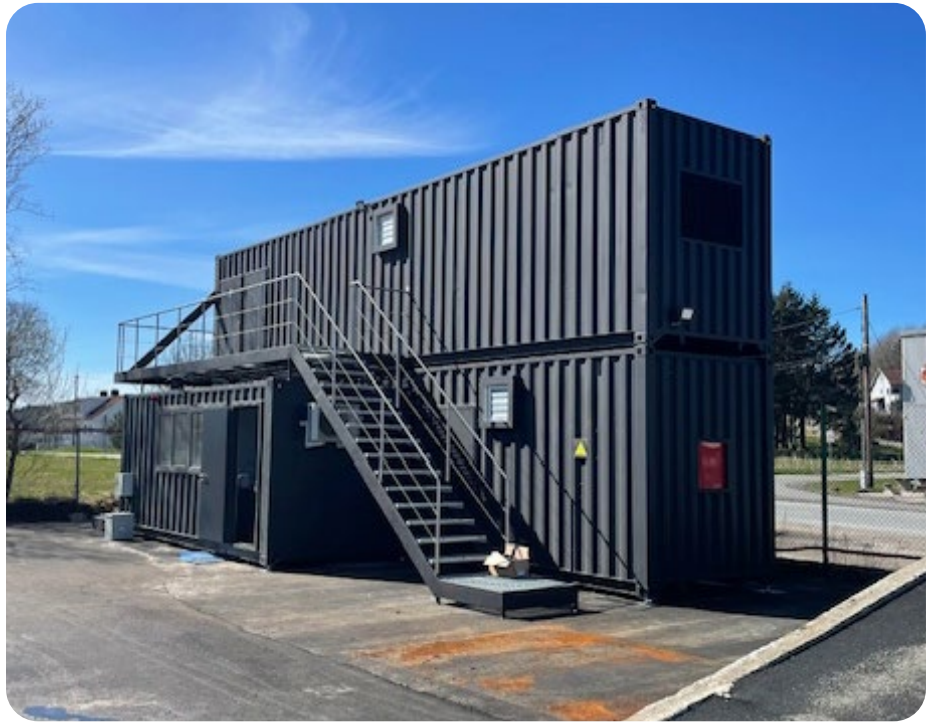
Nytt gassfyrte øvingsanlegg ble plassert ved stasjonen i Søgne i mars 2024.
